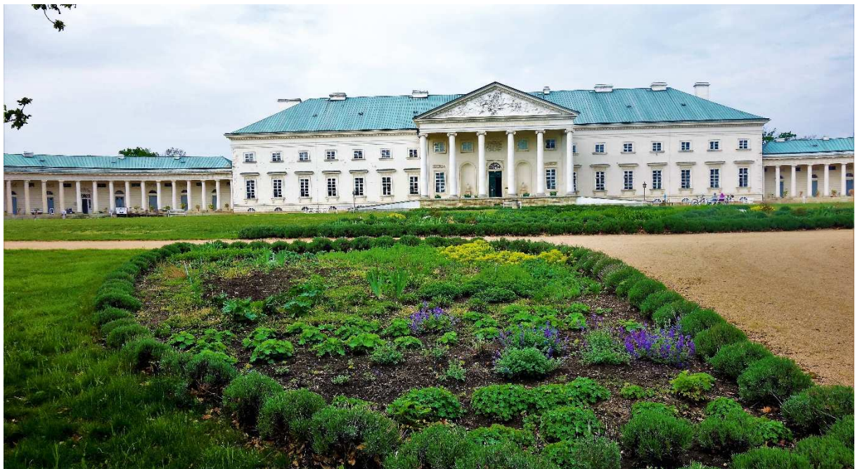
Hlavní průčelí zámku Kačina od východu. Foto: Zdeněk Lipský, 1.5.2019
